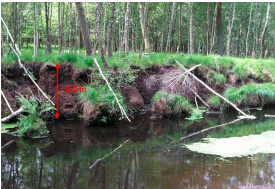
Fot 7. Głębokość drenażu Kanału C9 na Torfowisku Kluki. Fot. I. Chlost.
