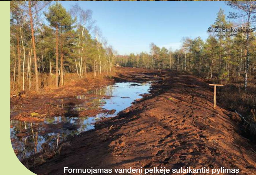
Formuojamas vandenį pelkėje sulaikantis pylimas
